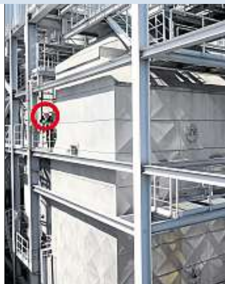
Riesiger Filter: Die Rauchgasreinigung der MVA entfernt 99 Prozent der bei der Verbrennung freigesetzten Schadstoffe. Fotos: MVA
