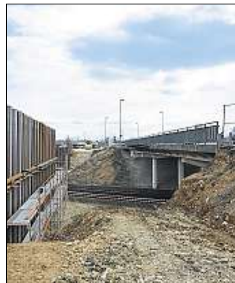
Links die neue provisorische Brücke, rechts die alte Brücke, die abgebrochen wird. Foto: Michel
